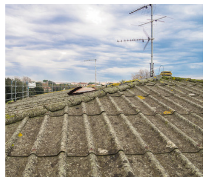
Abb. 10: und in Welldachplatten.
